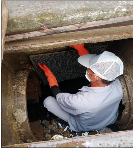
การทำความสะอาดตะแกรงดักมูลฝอย
