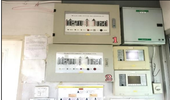
รูปที่ 1 ตู้ควบคุมระบบตรวจจับและแจ้งเหตุเพลิงไหม้
