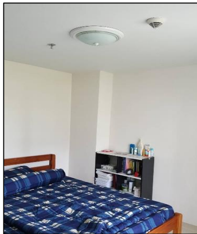
รูปที่ 3 ระบบสปริงเกอร์ และอุปกรณ์ตรวจจับเพลิงไหม้
